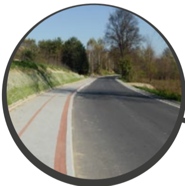
Modernizacja drogi w Borzęcinie
