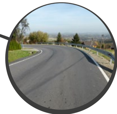
Modernizacja drogi w Tymowej
