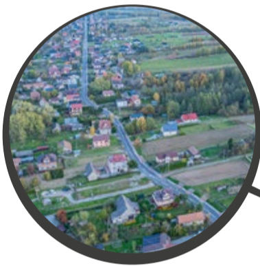
Modernizacja ul. Witosa w Jadownikach
